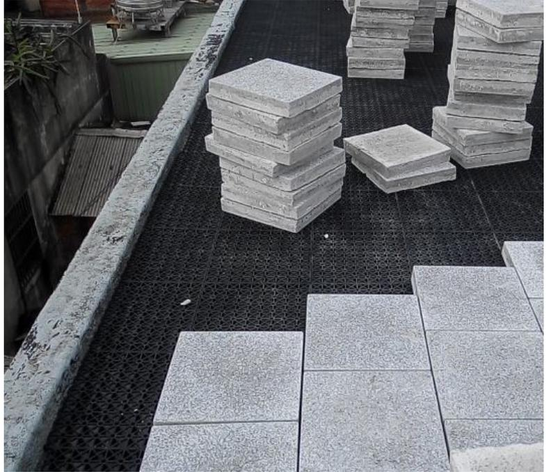
步驟二：將隔熱磚直接置於排水板上，
